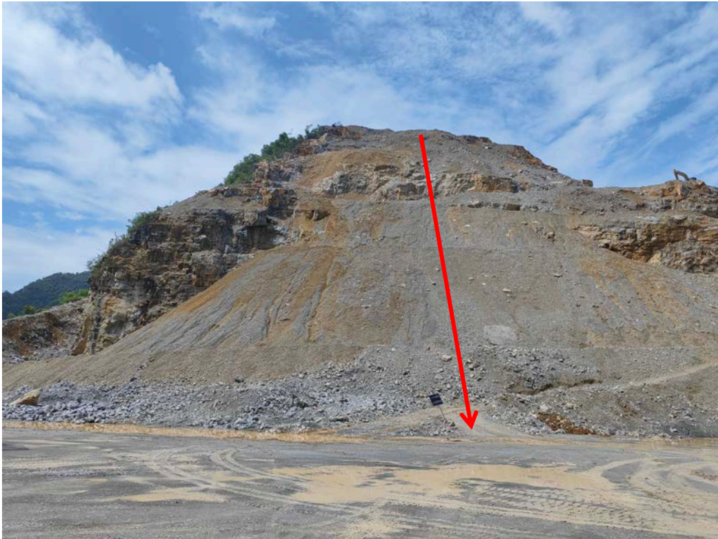
照片 5.1-1 不稳定斜坡现场照片
