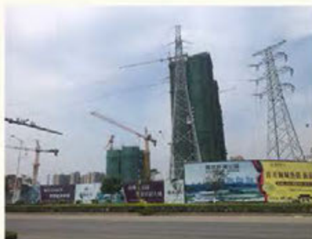
C. 鼎源壹号（建设中）
